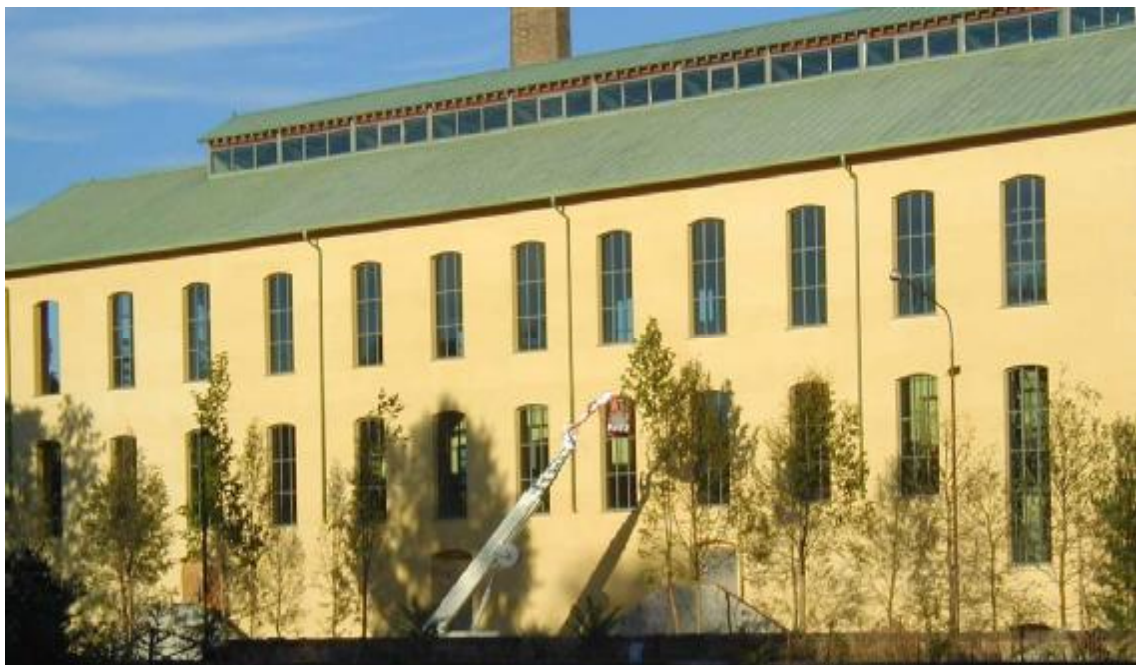
DOPO POSA ALBERI A LATO DELLO STABILIMENTO
