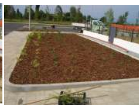
Posa tubo irrigazione e corteccia
